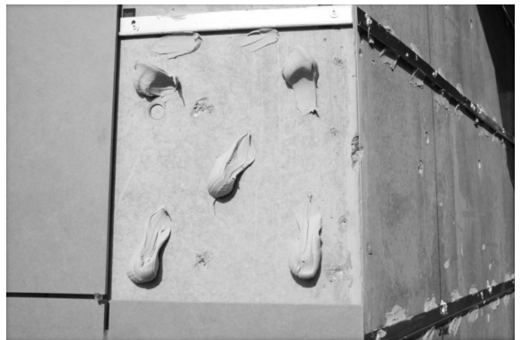
写真 「ガチロック」工法の弾性接着剤
