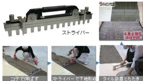
図5 ストライビング工法
