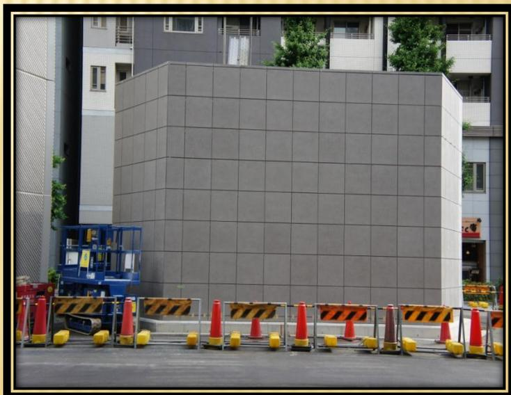
ME-05は、屋外壁面タイル施工用(落下防止金物併用)として開発された一液反応硬化形の变成シリコーン・エポキシ樹脂系接着剤です。
