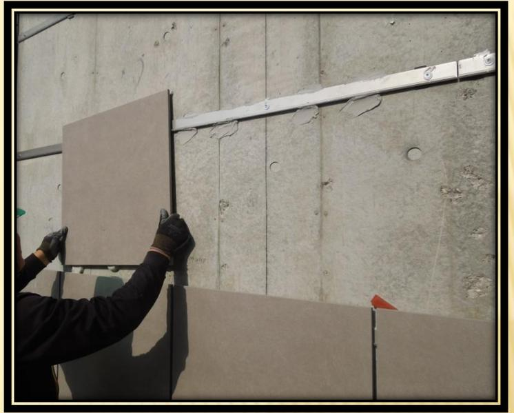
⑭ タイル側金具がレールに入り込んだのを確認し、タイルを押し付ける
